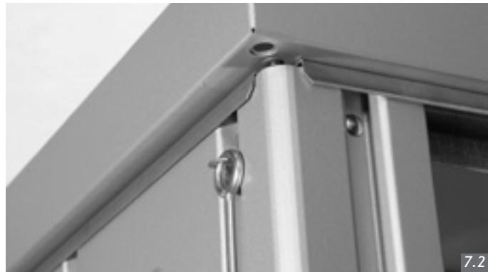
**F** Posez la tôle de toit sur les parois latérales/ profil de tête et faites attention au positionnement correct de la tôle de toit ainsi que du support de toit **F**. Vissez la tôle de toit aux 4 coins et 2 fois à la paroi arrière avec le profil de tête **B**.
