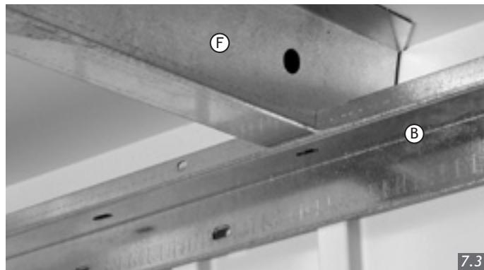
**NL** Leg nu de dakplaat op de zijwand / kopprofielen en let op de correcte positie van het dak en ook het daksteun **F**. Zet het dak aan de 4 hoeken vast en 2 maal aan de achterwand met de kopprofielen **B**. Voor het centreren van de gaten gebruikt u de meegeleverde spijker. De daksteun **F** schroeft u aan het kopprofiel links en rechts met een schroef vast. (het dak nog niet aan het voorste kopprofiel vastschroeven!).
